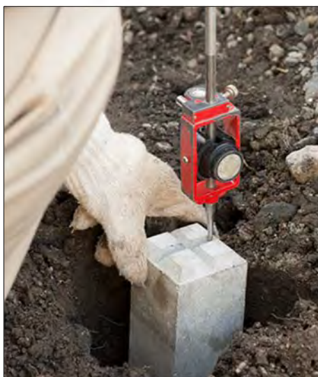
暑い時期の埋設作業は大変
