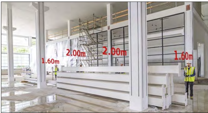
写真6: 視通を確保するためにポール高さを変える場面
